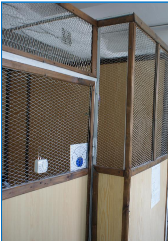
Rys. 18. Przykład ekranowania elektromagnetycznego kabiny zabiegowej z diatermią fizykoterapeutyczną (źródło: archiwum własne)
